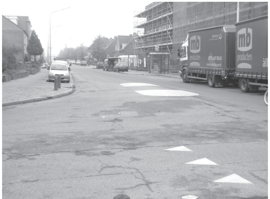
De kruising Willemsweg-Thijmstraat, die helemaal op de schop gaat naar aanleiding van de bouw van het voorzieningshart.
