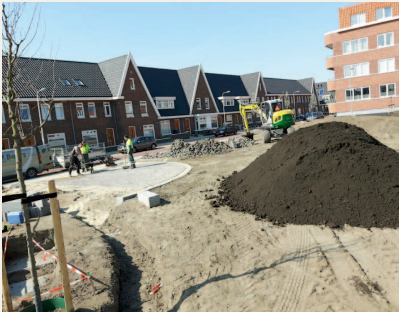
Werkzaamheden parkje Spiegelhof
