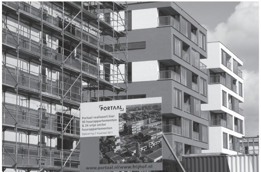
de laatste huurappartementen in aanbouw in de Ploegstraat
